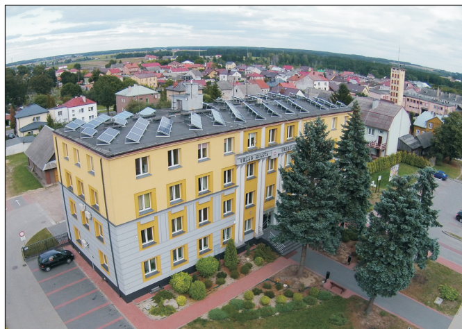
Panele fotowoltaiczne zainstalowane w ramach projektu „Energia słoneczna pracuje dla Miasta Kolno” na budynku Urzędu Miasta...
