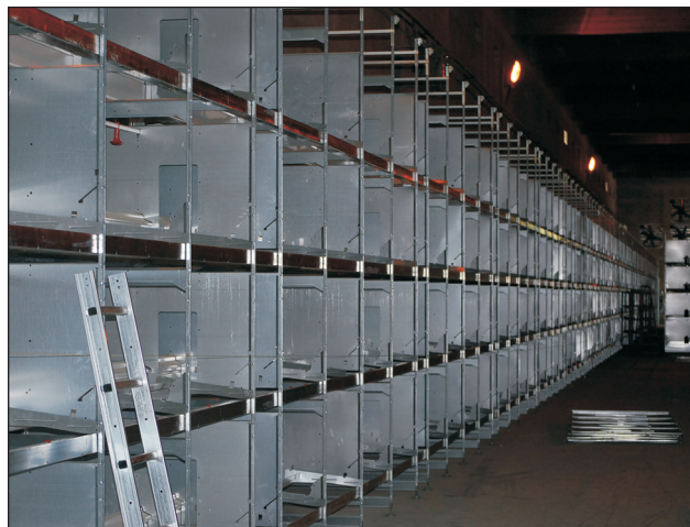
Wnętrze kurnika w budowie
