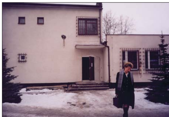
Budynek Banku Spółdzielczego w Grabowie przed modernizacją
