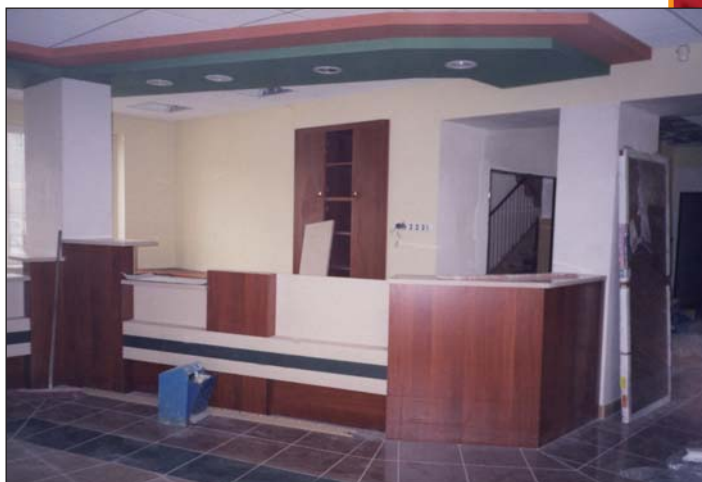
Sala operacyjna grabowskiego Oddziału po modernizacji Banku Spółdzielczego w Kolnie
